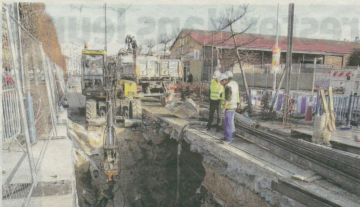
LA COURNEUVE, HIER APRÈS-MIDI. Il faudra encore une semaine à Veolia pour réparer la grosse canalisation souterraine. Puis la RATP prendra le relais pour refaire la voie. (LP/N.P.)
