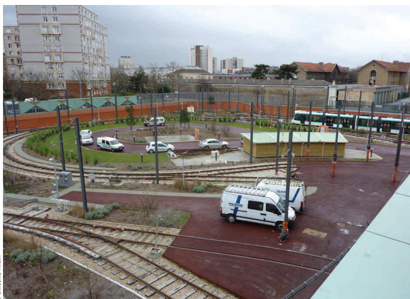
L'espace de stockage des rames du tramway du site de maintenance et de remisage du T2 à Bezons.
