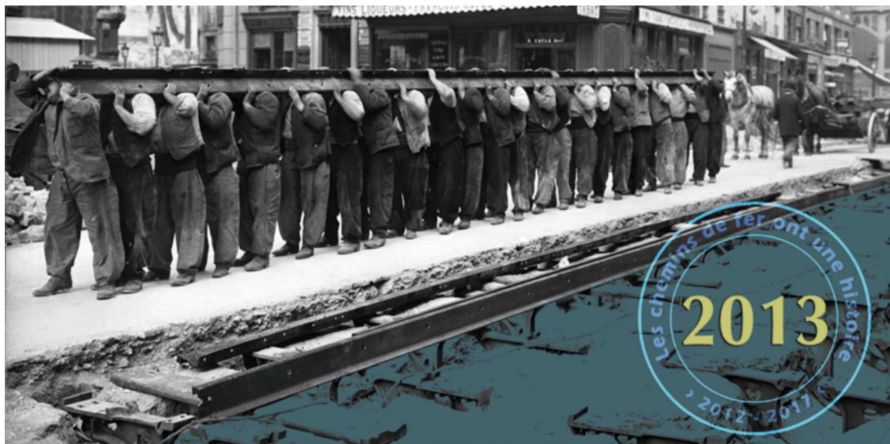
"Ouvriers posant un rail pour la compagnie des omnibus de Paris"
