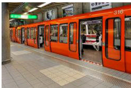
Dalles de pré-repérage dans les stations de la ligne D du métro lyonnais. © Philippe Schuller.
