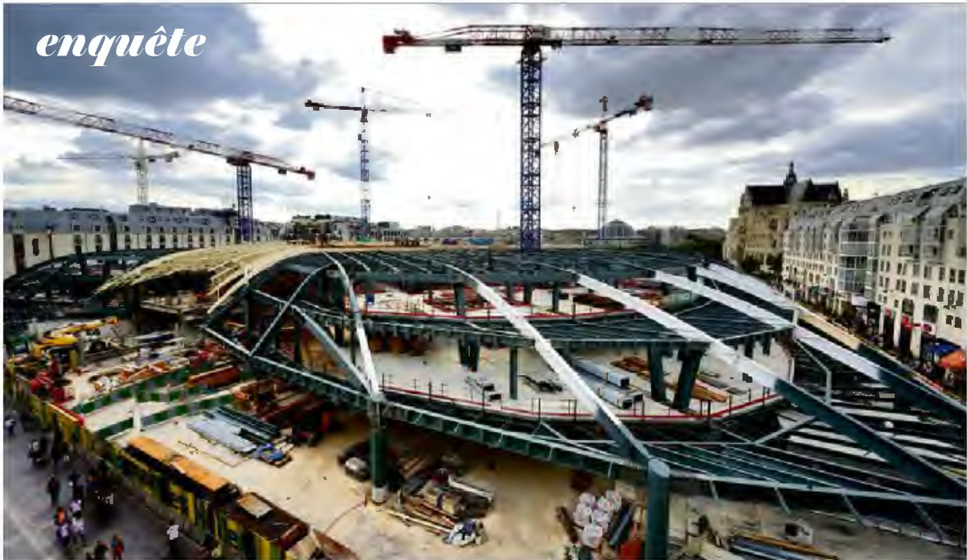
Chantier de la Canopée du Forum des Halles, des architectes Patrick Berger et Jacques Anziutti, à Paris. Photo Eric Feferberg/AFP
