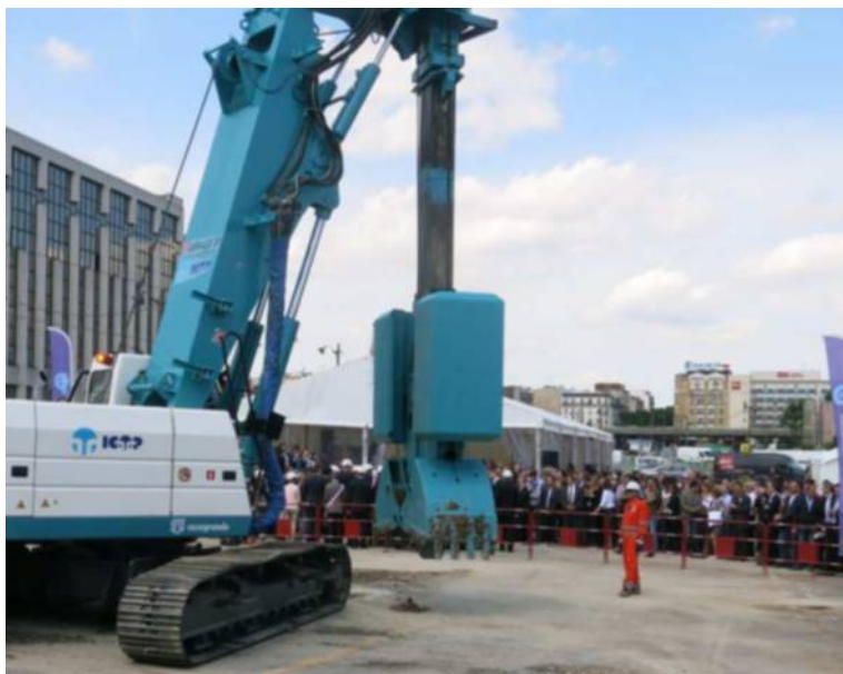
Porte de Clichy (XVII e ), hier matin. Le premier coup de pelleuse du prolongement de la ligne 14 a rassemblé de nombreux élus. (LP/B.H.)
