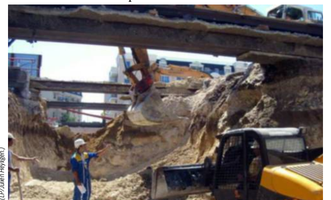
La Société du Grand Paris promet d'éviter trop de « norias de camions » lors des travaux d'excavation.
