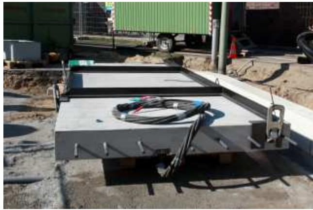
3 de 5 : La station de charge PRIMOVE, juste avant d'être ensevelie.
