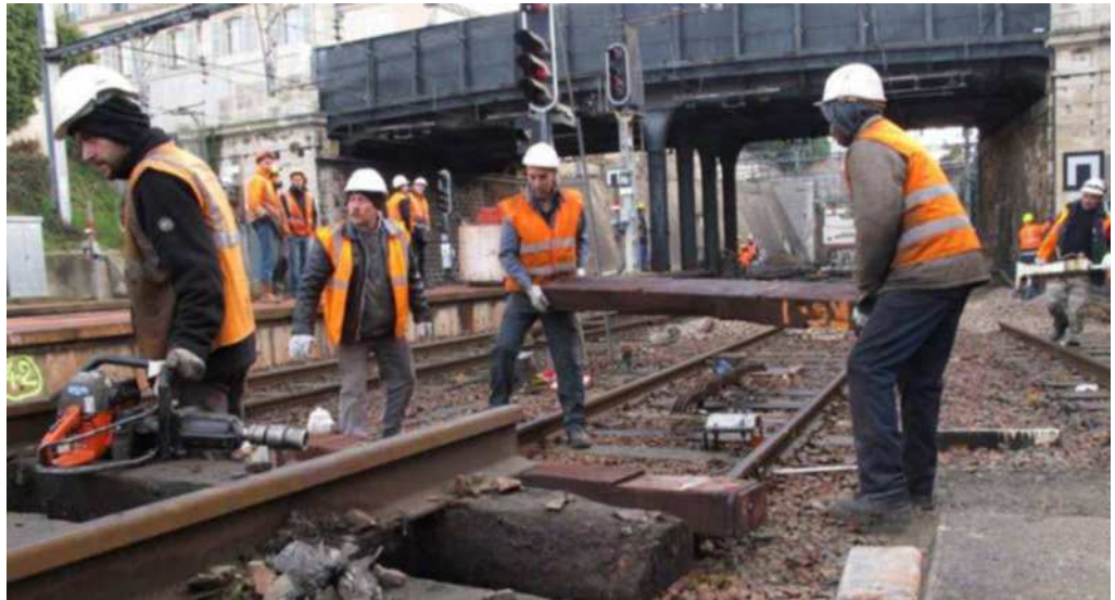
Remplacement des rails, des aiguillages, changement de caténaires, renforcement des sous-stations électriques pour supporter l'augmentation du trafic... 13 000 personnes vont œuvrer, pendant 5 ans, à la remise à niveau des infrastructures du réseau. (LP/Mehdi Gherdane.)
