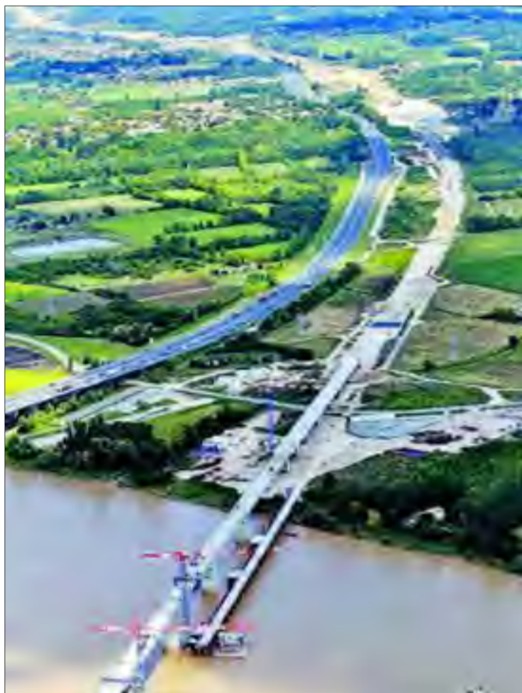
Les travaux de la LGV pour le franchissement de la Dordogne à Saint-André-de-Cubzac (33) cet été. PHOTO LAURENT THEILLET/« SUD OUEST »
