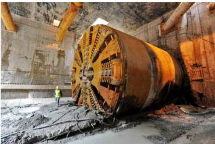
Tunnelier de la ligne 12 photo Bruno Marguerite © RATP
