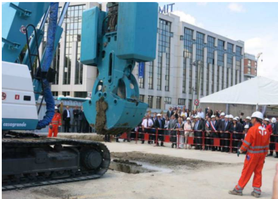
Paris, Porte de Clichy (XVII e ), le 11 juin. Le chantier du prolongement de la ligne 14 avait été lancé en grande pompe, en présence de nombreux élus. Quatre mois plus tard, l'enthousiasme est retombé : les travaux seraient plus difficiles que prévu. (LP/Benoît Hasse.)
