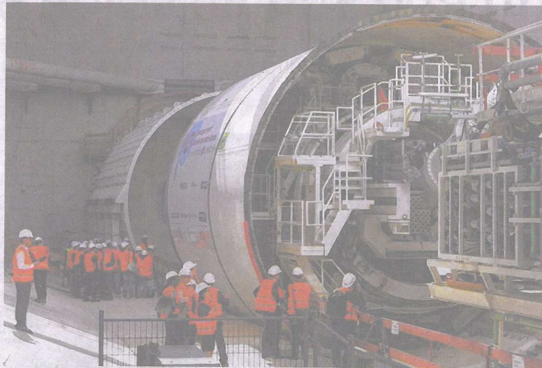
Paris (XVII e ), 149, rue Cardinet, hier. Véritable usine de 1 400 t, le premier tunnelier de prolongement de la ligne 14 du métro va commencer son œuvre. Une deuxième machine entrera en service à la fin de l'année. (LP/J.D.)
