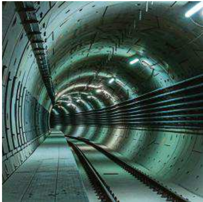
Les 1.800 km de câbles portant la fibre optique se fondent dans la masse de ceux assurant l'électricité ou la signalisation. Shutterstock
