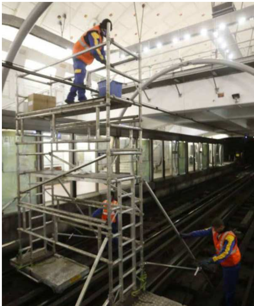
De nombreuses stations de métro seront fermées tout au long du printemps, et parfois jusqu'à la fin du mois d'août pour des travaux de modernisation. (LP/Olivier Lejeune.)
