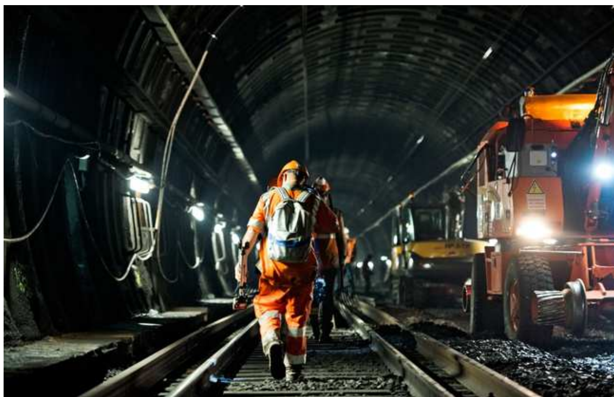
Le chantier du RER A entre la Défense et Auber - SIPA PRESS
