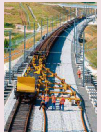
Pose des rails de 432 m pour la ligne LGV Paris-Bordeaux livrée en juillet 2017. JEAN MICHEL NOSSANT/SIPA
