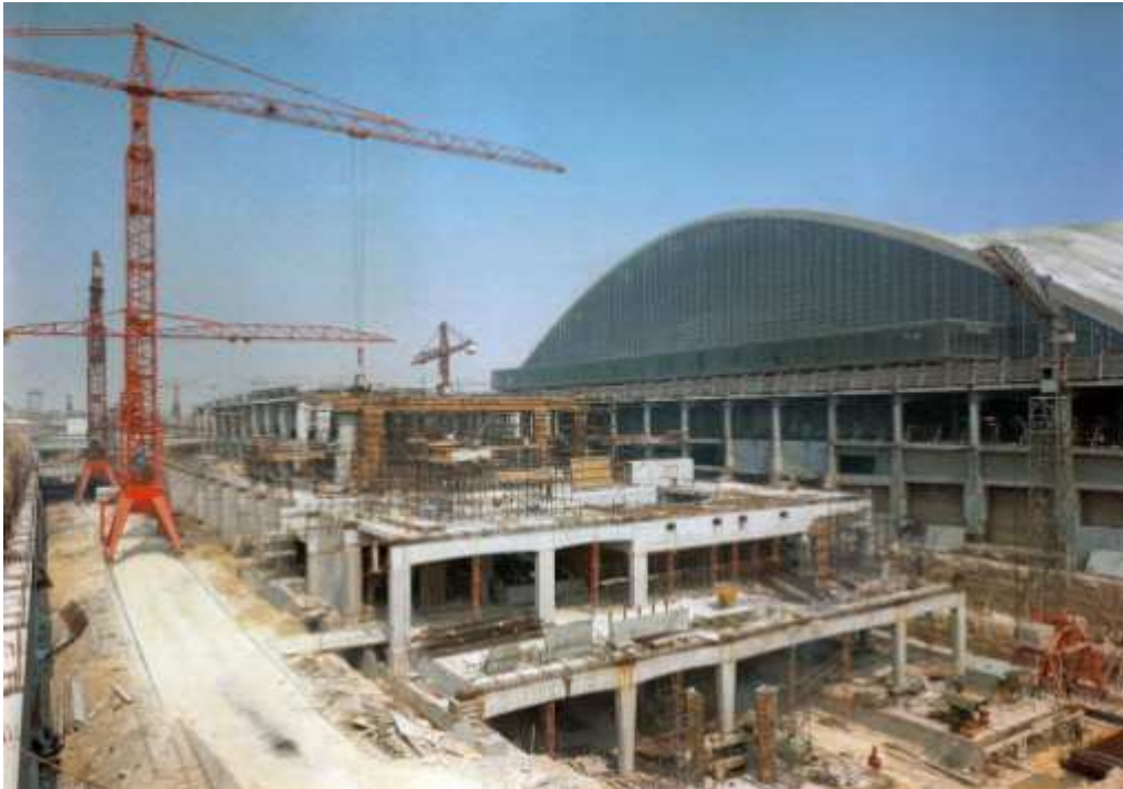
Chantier de construction du RER à LA Défense en 1966 (©RATP/DR)
