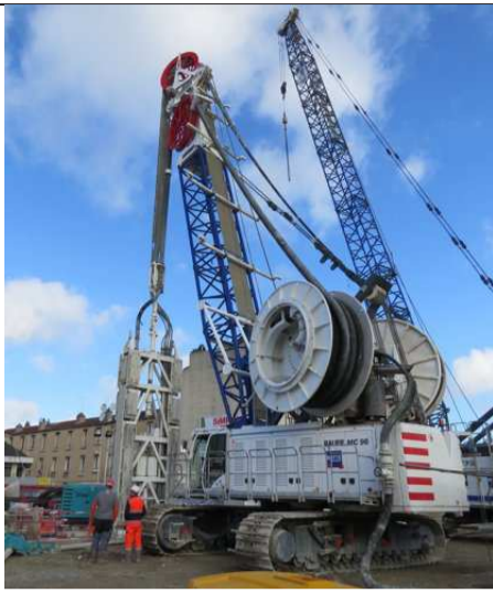
Aubervilliers (Seine-Saint-Denis), le 29 mars. Les travaux se déroulent principalement à 20 m sous l'avenue Victor-Hugo. Ci-dessus à droite, voici l'hydrofraise, une super foreuse qui creuse les tranchées afin d'y couler le béton des parois. (LP/N.R.)
