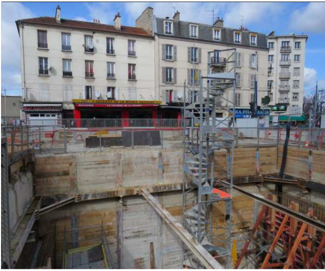
Aubervilliers (Seine-Saint-Denis), le 29 mars. Les travaux se déroulent principalement à 20 m sous l'avenue Victor-Hugo. Ci-dessus à droite, voici l'hydrofraise, une super foreuse qui creuse les tranchées afin d'y couler le béton des parois. (LP/N.R.)
