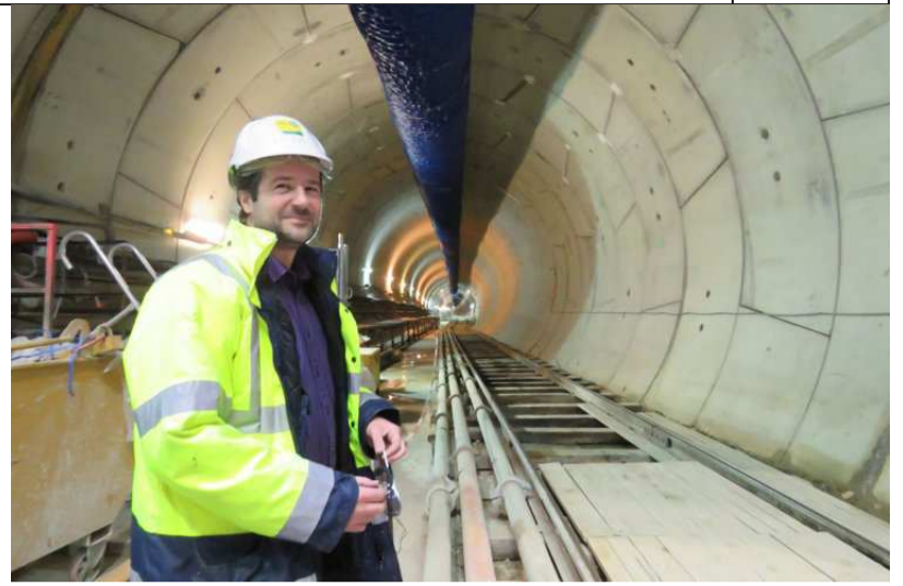
Laurent Chassagne, chef de projet à la RATP, dans le tunnel qui relie Aimé-Césaire à Mairie-d'Aubervilliers. Des tuyaux permettent d'acheminer le béton et d'évacuer les boues. (LP/N.R.)
