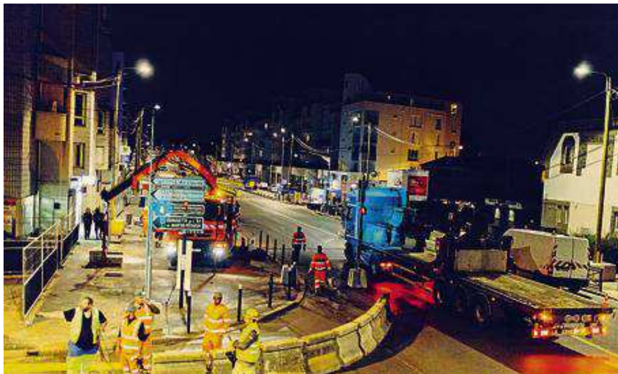
LA LIGNE 15 SUD , ici les travaux à Champigny, sera longue de 33 kilomètres et desservira 16 gares, dont celle de Saint-Maur-Créteil. Photo Genaro Bardy / Société du Grand Paris
