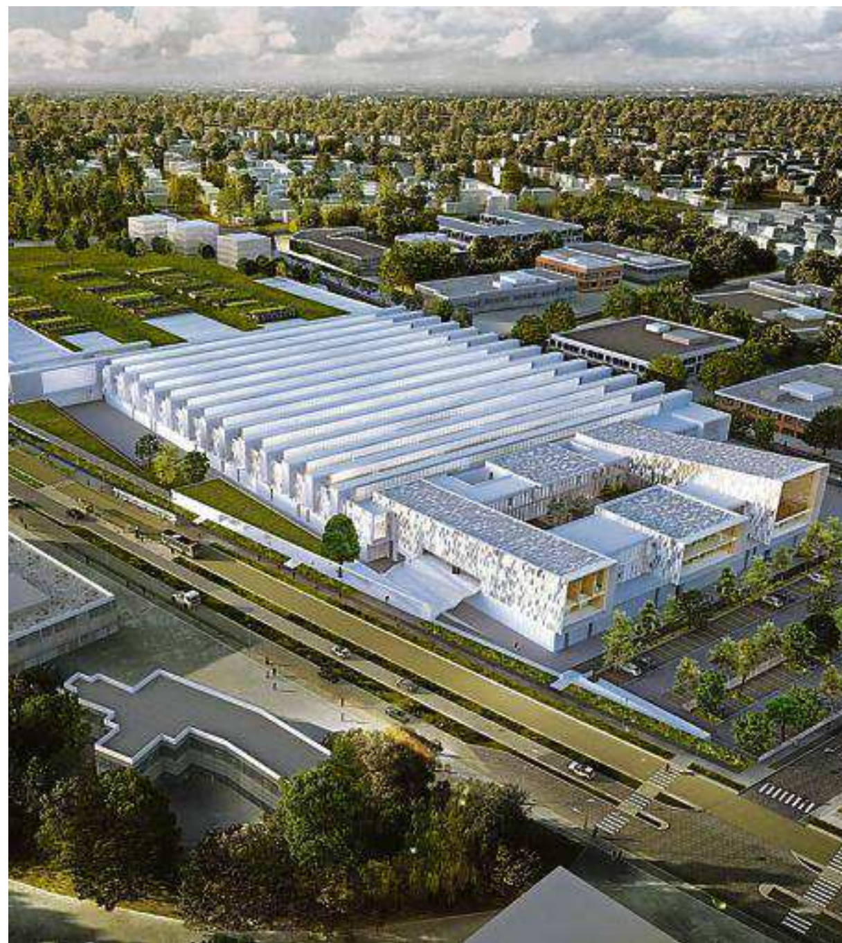
LE FUTUR SITE de Champigny-sur-Marne assurera l'entretien du matériel roulant et créera 450 emplois.
