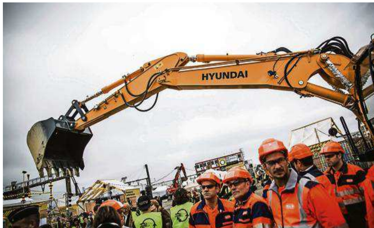
Le Grand Paris (ici, lancement des travaux à la gare de Clamart) oblige, selon Orso Vesperini, responsable du dossier Grand Paris chez NGE, « à redimensionner l'outil de travail pour répondre à l'enjeu ». Photo RGA/RÉA
