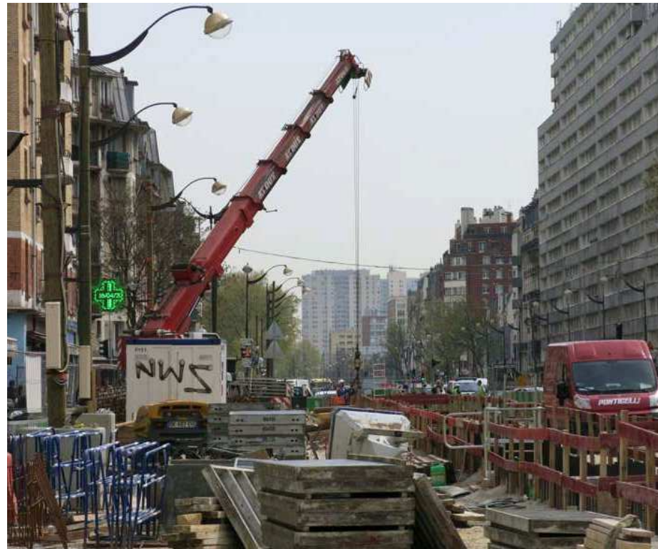
Boulevard Ney (XVIII e ), avril 2015. Les riverains des boulevards des Maréchaux, qui subissent les nuisances des travaux depuis deux ans, vont devoir encore supporter le bruit des engins jusqu'à l'automne 2018. (LP/J.D.)
