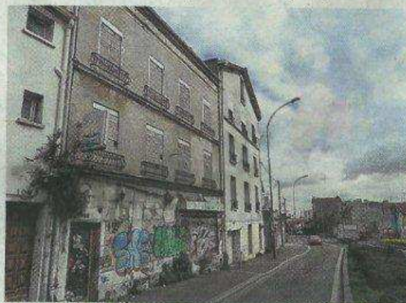
Noisy-le-Sec, jeudi. Les maisons sont en attente de démolition pour permettre le prolongement du T1 vers le Val-de-Marne mais les travaux sont bloqués. (PST)
