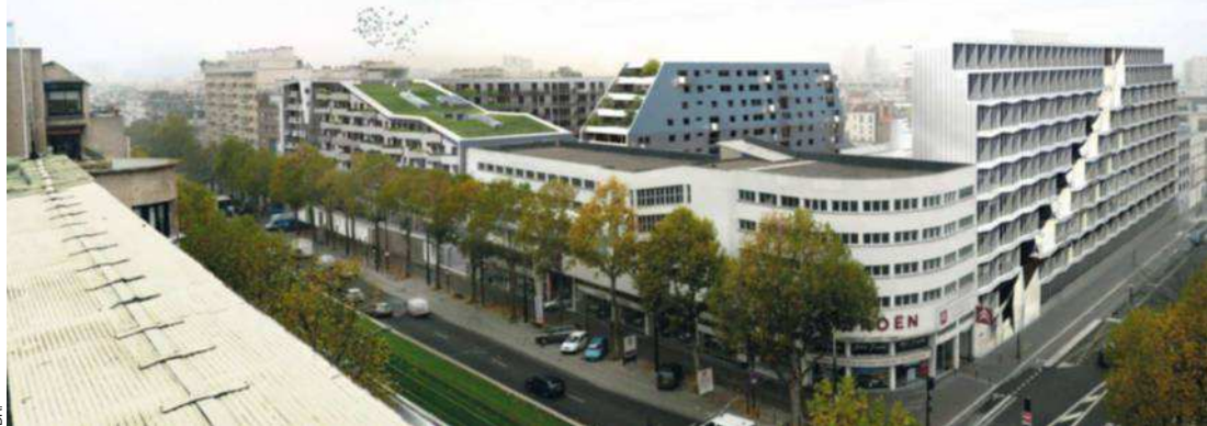
DR. Les Ateliers Jourdan-Corentin-Issoire (XVI e ). Le chantier est en cours au-dessus du dépôt de bus de la Porte d'Orléans.
