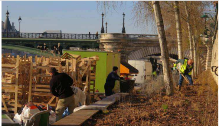
Paris (IV e ), lundi. Les travaux vont bon train sur les berges de la rive droite.
