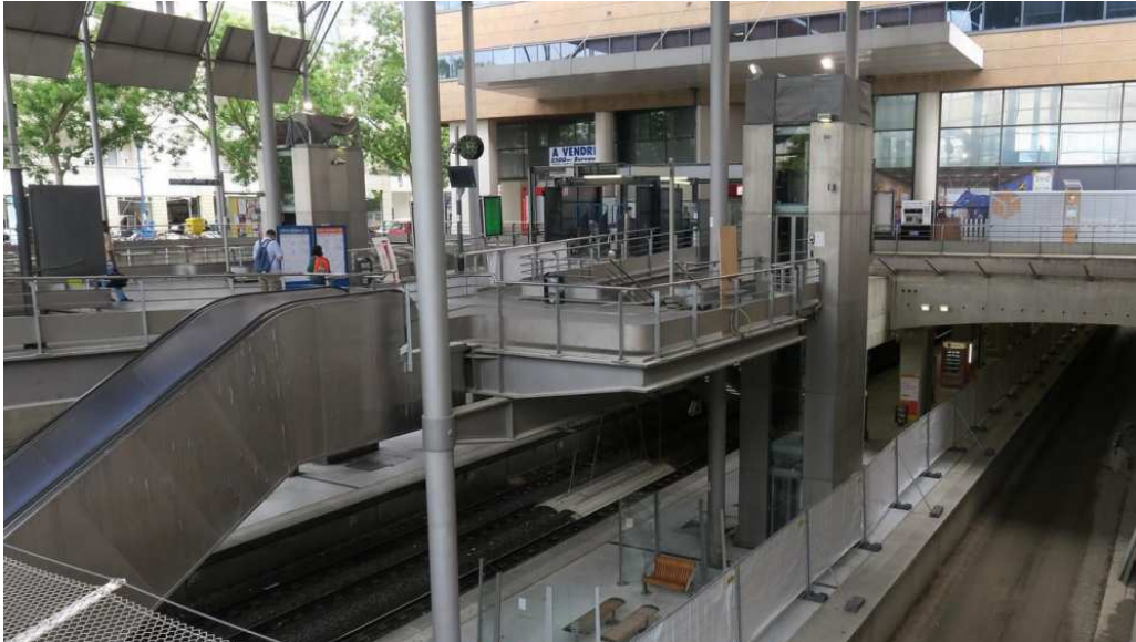
Cergy-le-Haut, ce jeudi 27 juillet 2017. La quatrième voie en construction (à droite) permettra de réduire les retards et perturbations sur les lignes A et L. LP/Julie Ménard
