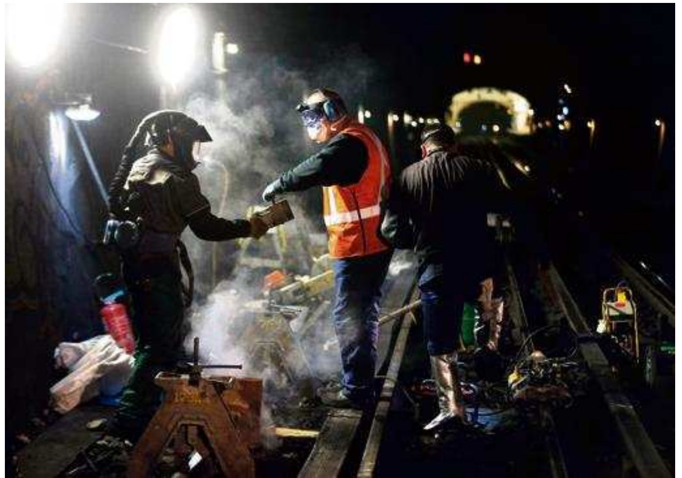
Travaux nocturnes près de la station Laumière, dans le nord-est de Paris, en 2013. FRANÇOIS GUILLOT/AFP
