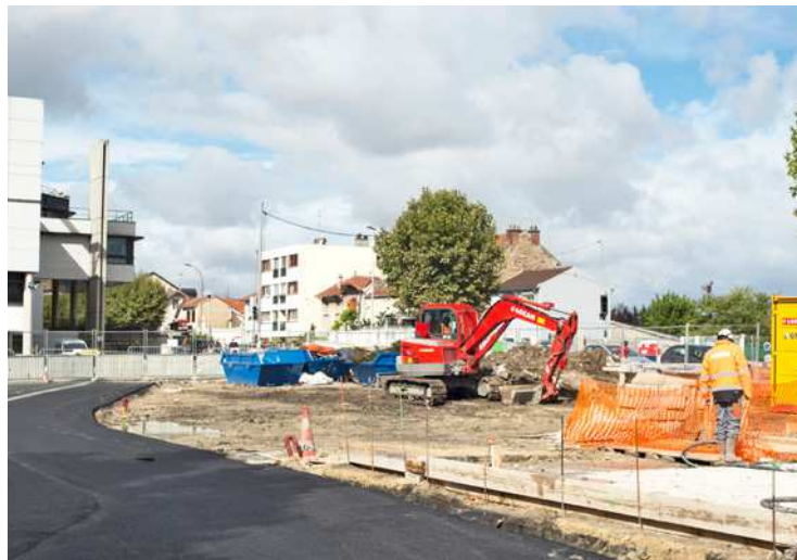
Le boulevard de la Boissière, fermé à la circulation à partir du 2 octobre, accueillera l'un des deux accès de la station.
