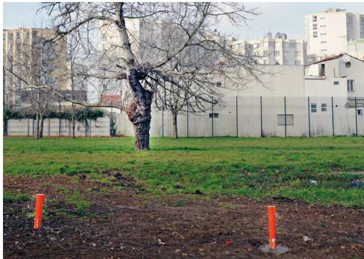
Les sondages géotechniques pour la future station Grands-Pêchers.
