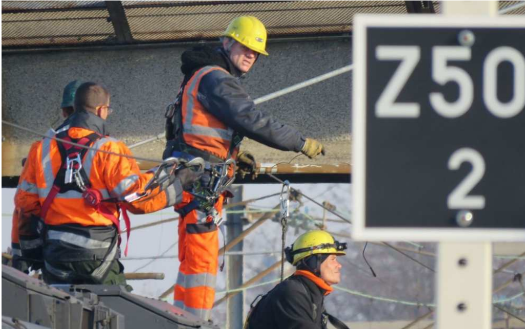
Aulnay, le 6 décembre. Des techniciens de la SNCF travaillent sur le toit du train de la ligne RER B au niveau de la caténaire qui a causé l'arrêt du trafic.LP/Jeremy Bouillard
