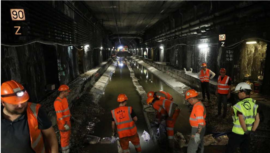
Paris, station Auber, le 31 juillet 2017. Sur la ligne du RER A, le chantier de renouvellement des voies et du ballast a débuté samedi. LP/ Philippe Lavieille
