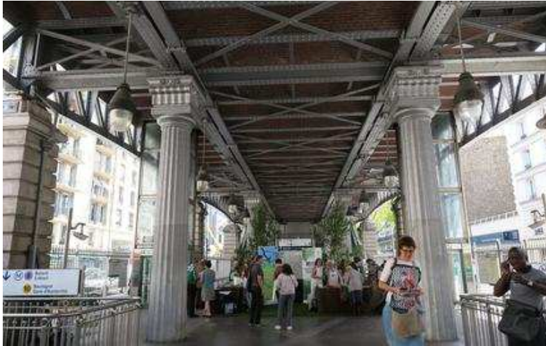
Les piliers de la station La Motte-Piquet-Grenelle. (LP/C.G.)
