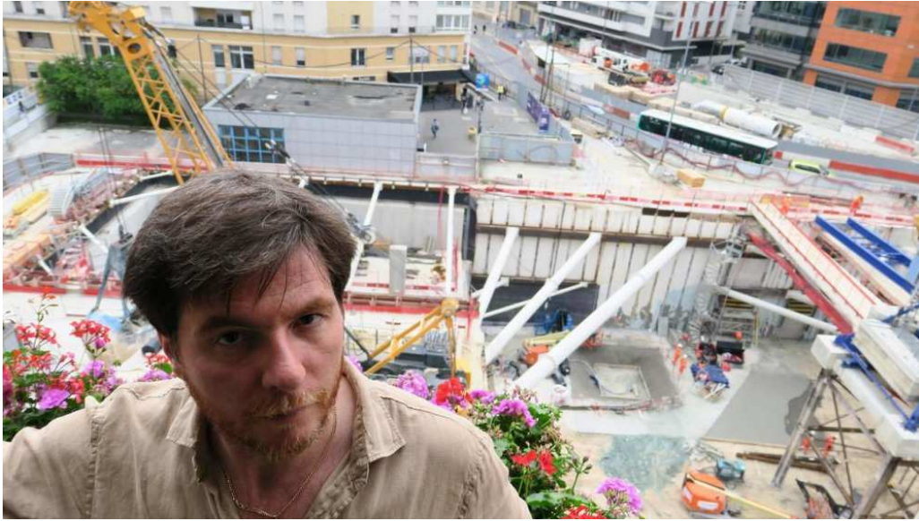
Saint-Ouen, mercredi 26 juillet. Les travaux de la future station de la ligne 14 se déroulent sous son balcon et exaspèrent Benjamin. LP/Gwenael Bourdon
