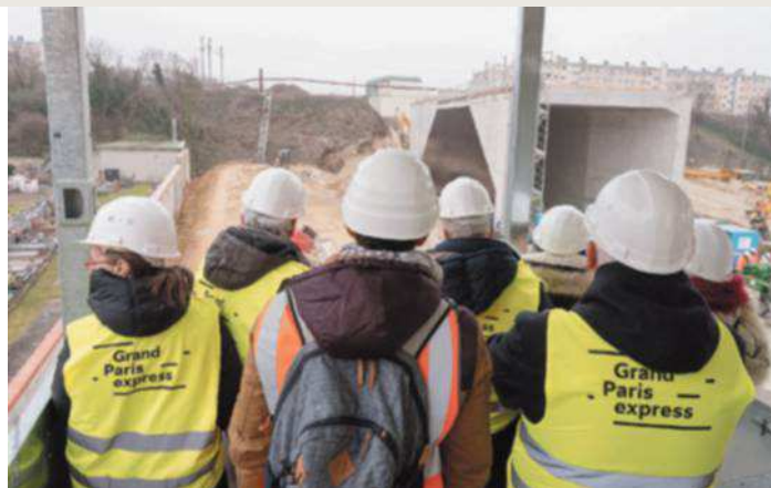
Visite commentée du chantier de la future ligne 15 à Champigny-sur-Marne, organisée par la Ville, la SNCF et la Société du Grand Paris, le 24 janvier dernier. SOCIÉTÉ DU GRAND PARIS/GÉRARD ROLLANDO
