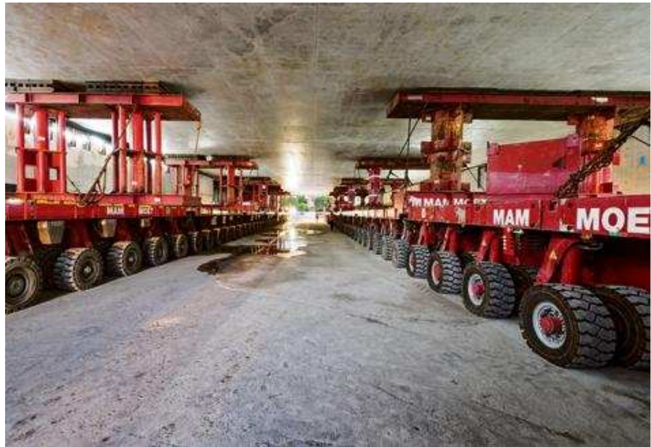
Travaux au Fort d'Issy-Vanves-Clamart, future station de la ligne 15 du métro.
