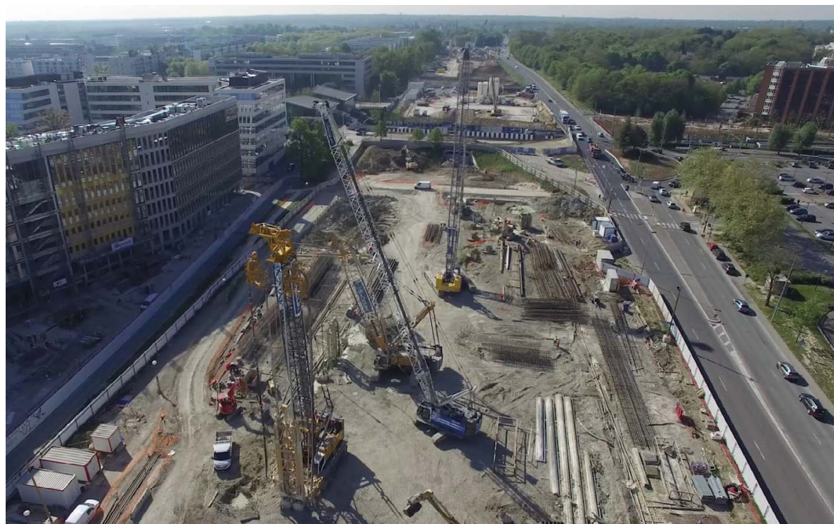
Le chantier de la gare Noisy-Champs qui accueillera la ligne 15 Sud du grand Paris express. © DR
