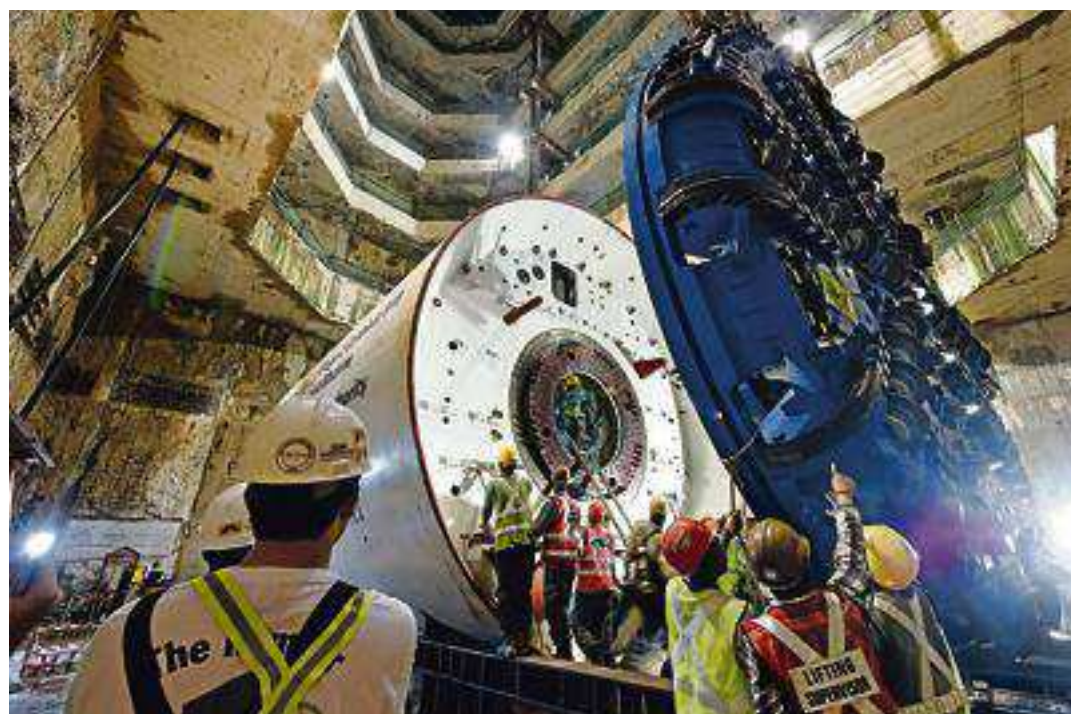
Dans l'un des ateliers d'Herrenknecht, une dizaine d'hommes s'affairent sur une roue de coupe de 550 tonnes qui viendra se fixer à l'avant d'une des machines de percement. Photo Herrenknecht
