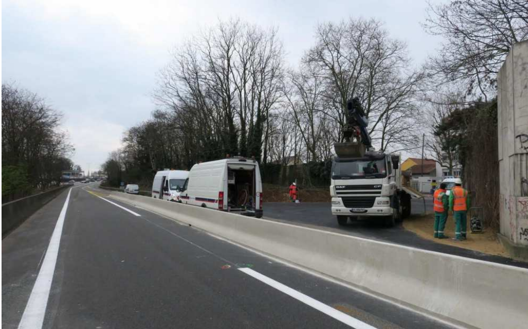
Villejuif. Les travaux d'ouverture d'une bretelle d'accès directe à l'A6 pour évacuer notamment les déblais de la future gare de l'IGR doivent éviter la circulation des camions en centre-ville. LP/Laure Parny
