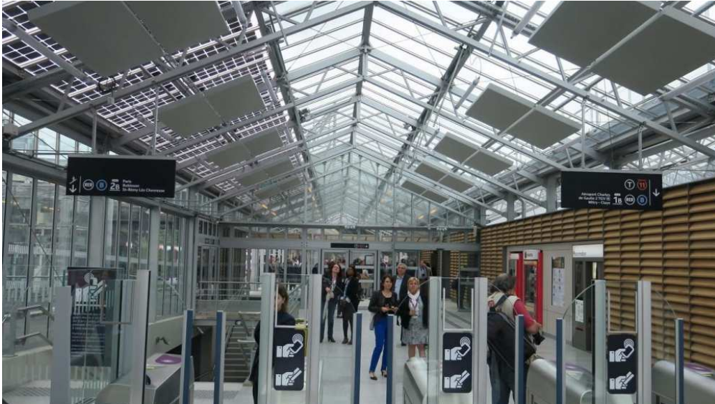
Le Bourget, ce vendredi. Des panneaux photovoltaïques sont installés sur le toit des gares du T11. (LP/J.-G.B.)
